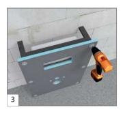
Une fois découpé, le panneau I-Board doit être fixé mécaniquement sur l'installation murale au moyen des vis à fixation rapide fournies et des rondelles wedi.
