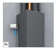
Appliquer la bande d'armature autocollante wedi Tools sur le raccord d'angle.
